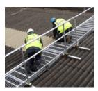
Echelles et passerelles de toit sont des éléments métalliques (généralement en aluminium) destinés à sécuriser le déplacement sur des surfaces fragiles (plaques de fibres-ciment, par ex.) Les échelles pour accéder en hauteur et les échafaudages sont des équipements également beaucoup employés.
